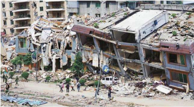
D'importants dégâts observés après les secousses
