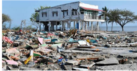
Dégâts observables après un séisme en Indonésie
