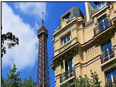
immeuble ancien parisien
